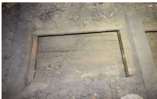
odkrywka stropu strychowego-przy ścianie środkowej podłużnej
