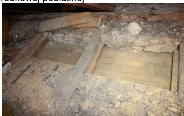
odkrywka stropu strychowego-przy ścianie wschodniej-przy okapie
