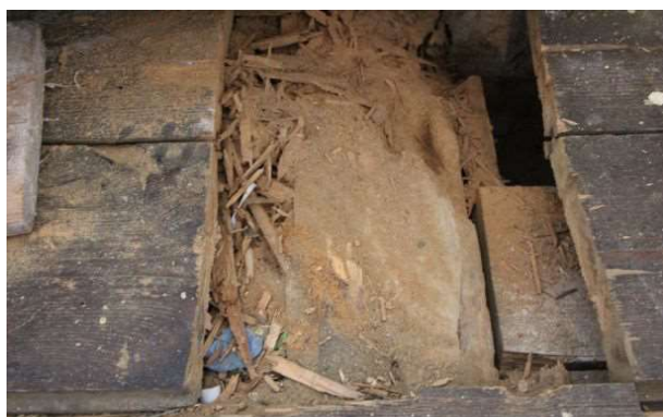
odkrywka stropu n.parterem z 7.03.2020r
