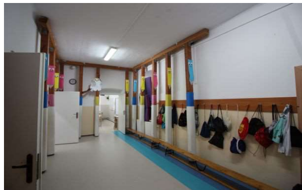
korytarz na parterze-widok podparcia stropu
