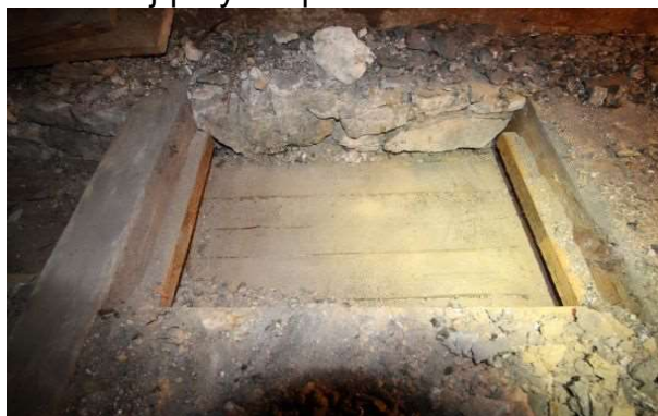
strop strychowy przy ścianie wschodniej- dobry stan belek stropowych
