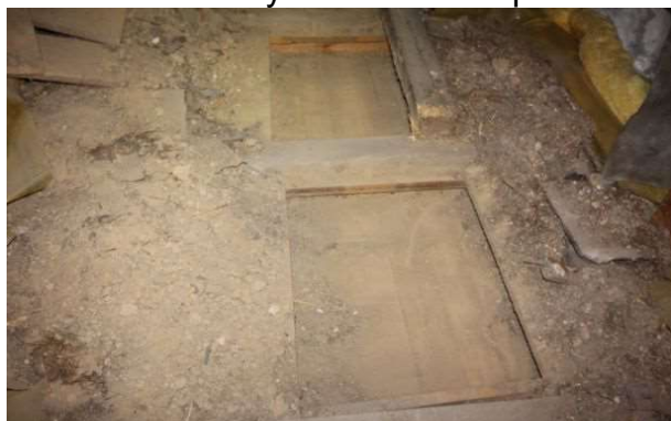
odkrywka stropu strychowego-trakt południowy
