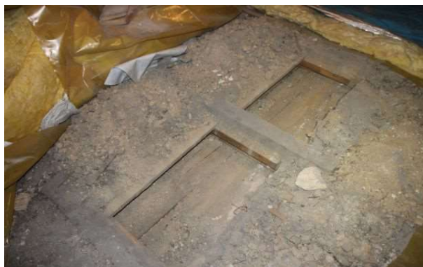
odkrywka stropu strychowego-trakt wschodni
