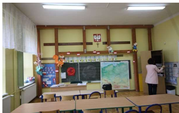
sala na piętrze -widok podparcia stropu
