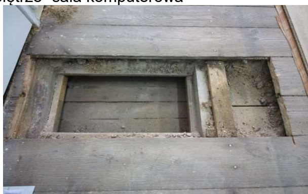
widok odkrywki str. n. parterem-strefa środkowa traktu dydaktycznego-sala komputerowa
