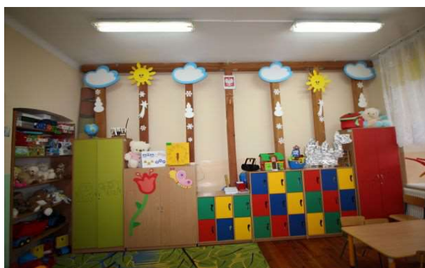
sala na parterze-widok stemplowania stropu
