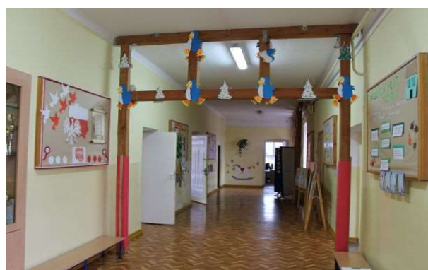
korytarz na piętrze-widok podparcia stropu
