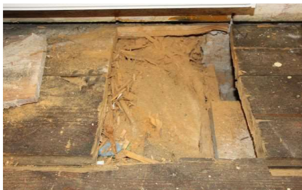
odkrywka stropu n.parterem z 7.03.2020r
