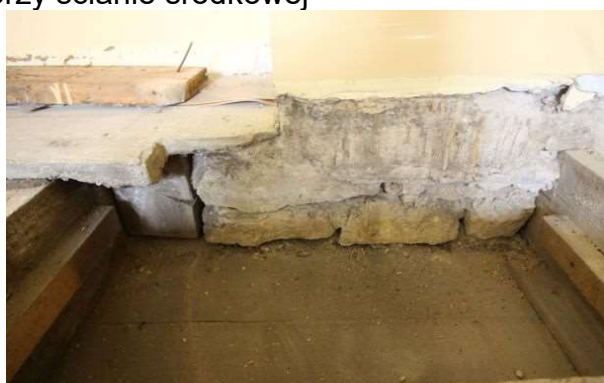
odkrywka stropu n. parterem z 13.05.2020r przy ścianie środkowej
