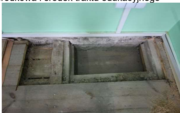
dobry stan belek przy ścianie środkowej na piętrze- sala komputerowa
